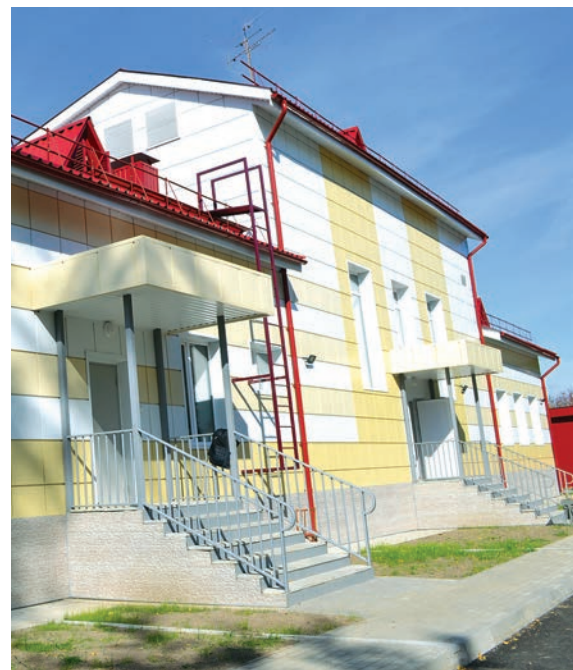
■ Современное здание центра культуры возведено в рекордно короткие сроки – на строительство затрачено менее одного года.
